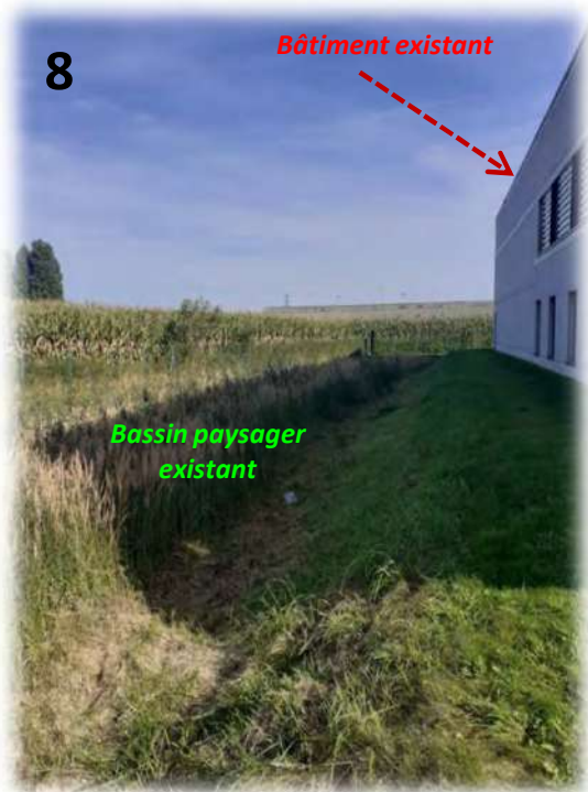
Vue sur les aménagements existants
