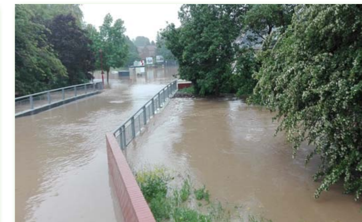
Le pont Lamendin à Bruay-la-Buissière (source : DREAL HdF)
