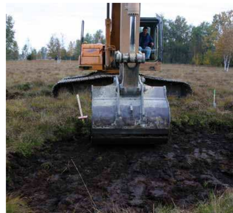
L'étrépage permet de recréer des zones nues favorables à l'installation du Liparis de Lœsel. Ici, la tourbière de Frasné (25). photos : J. Guyonneau/CBNFC
