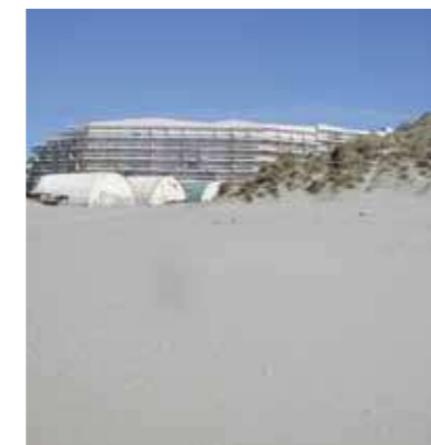
Les constructions dans les dunes, véritable fléau pour le fonctionnement des écosystèmes, constituent l'une des causes de la régression des populations de Liparis. photo : V. Cohez
