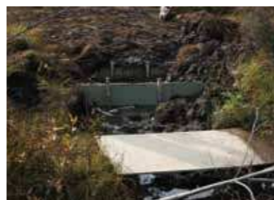
La fermeture étanche des anciens fossés de drainage permet de stabiliser les niveaux d'eau des sites accueillant des populations de Liparis de Lœsel. photo : J. Guyonneau/CBNFC
