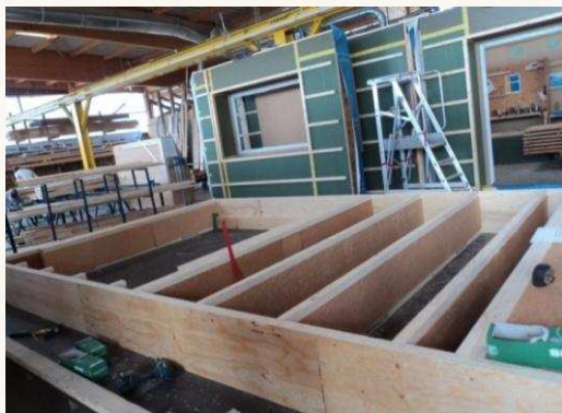
Atelier de préfabrication des « caissons » passifs avec isolation paille
