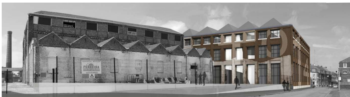
La ruche d'entreprise TO14 : Béal-Blanckaert Architectes. (TO13 en premier plan : non encore réhabilité).
