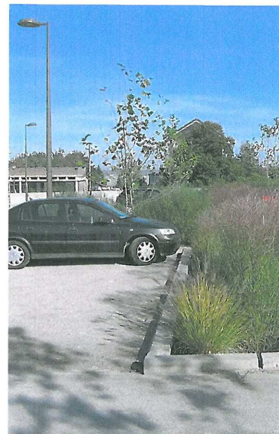
Parking Les Corderies - Saint-Valery-sur-Somme: Utilisation de matériaux poreux et intégration de végétation. Arch. SumProject & JNC, 1999
