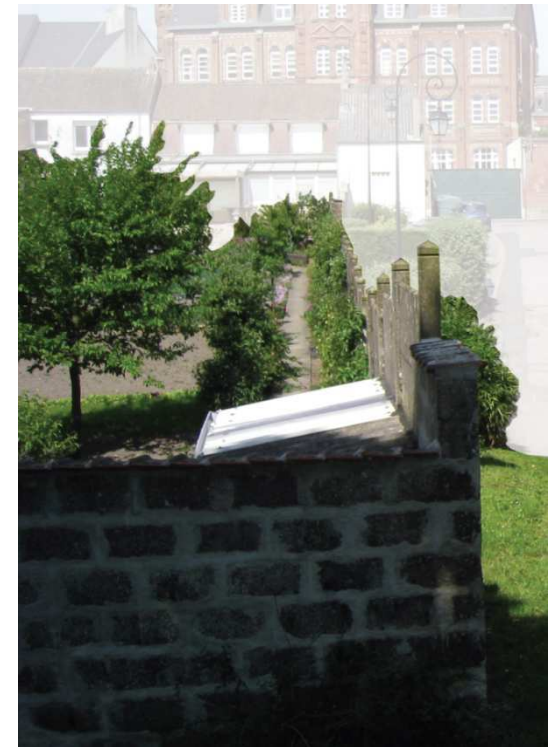
les annexes recouvertes de tôles ondulées sont très visibles.
