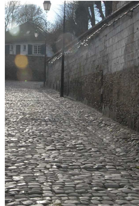
Exemple de recouvrement de sol durable et compatible avec le caractère historique de la Ville (rue du Clape en Bas).
