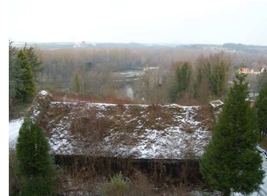
Vue sur la poudrière: La végétation aux abords des remparts n'est pas toujours constituée d'essences locales. Les sapins seront abattus.
