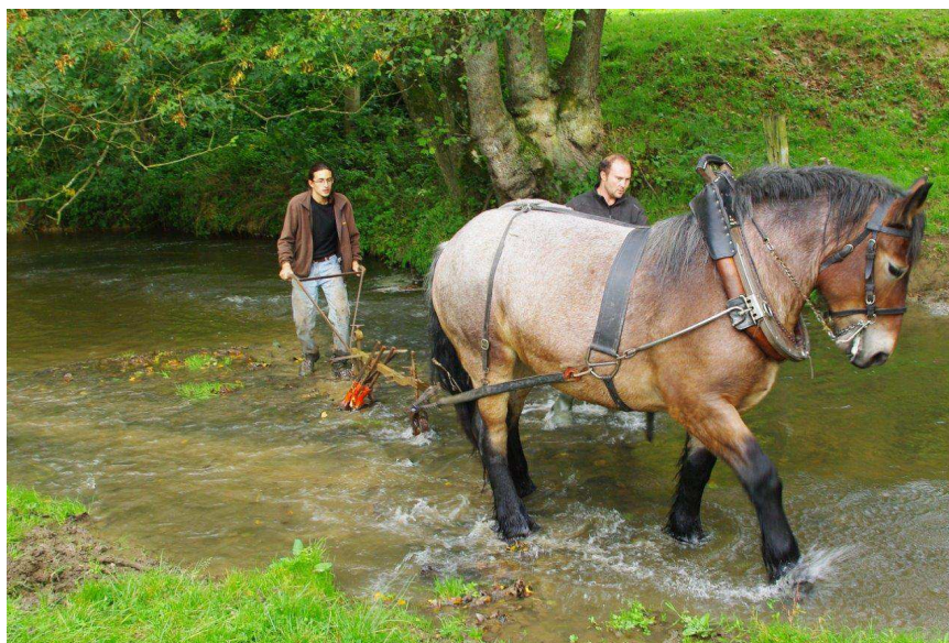
FIGURE 7 : OPERATION DE DECOLMATAGE AVEC CHEVAL DE TRAIT SUR LA SOLRE
