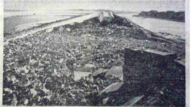
Une vue particulièrement saisissante de la plus importante des deux brèches créées dans la digue Tixier. — A droite, le canal existant et le bastion 22. (Photo Desormaux - M&G)
