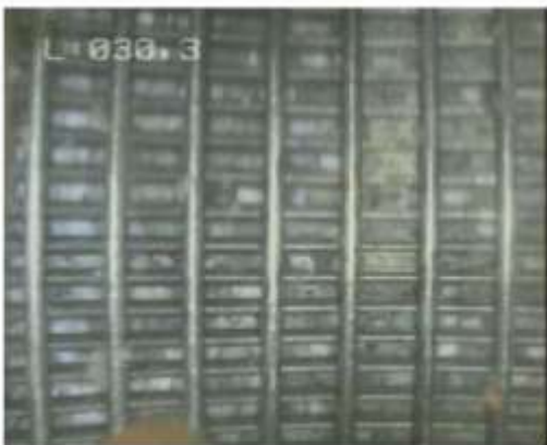
Passage caméra : observation de l'état des crépines et du massif de gravier
