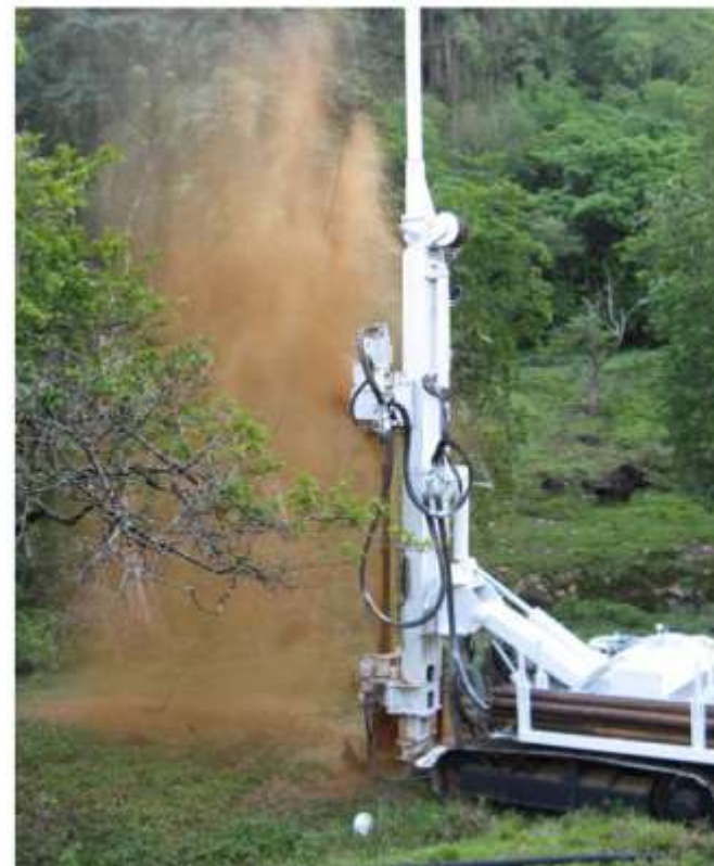
Air-lift : Nettoyage d'un forage
