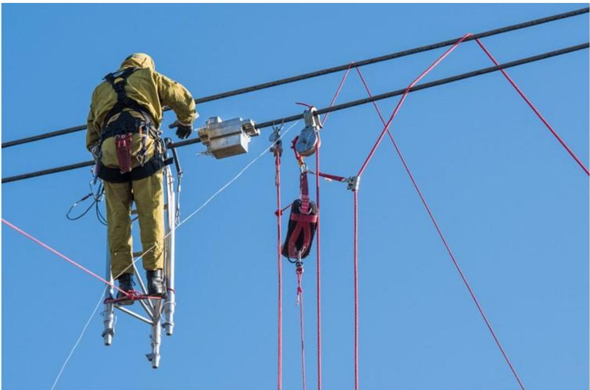
Figure 5 : Pose de capteurs DLR sur une ligne haute tension (copyright Caroline Dutrey)
