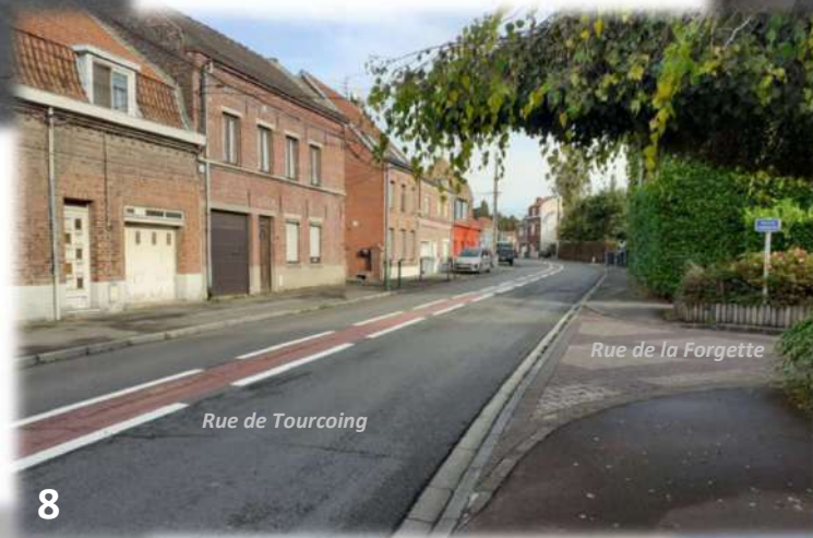
Vue sur la Rue de Tourcoing (intersection Rue de la Forgette)
