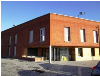
Résidence Sociale « les Horizons » Fresnes Sur Escaut
