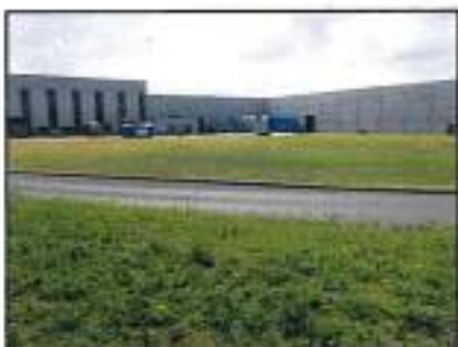
Photo 9 : Bâtiment industriel (Raiette, 2019)
