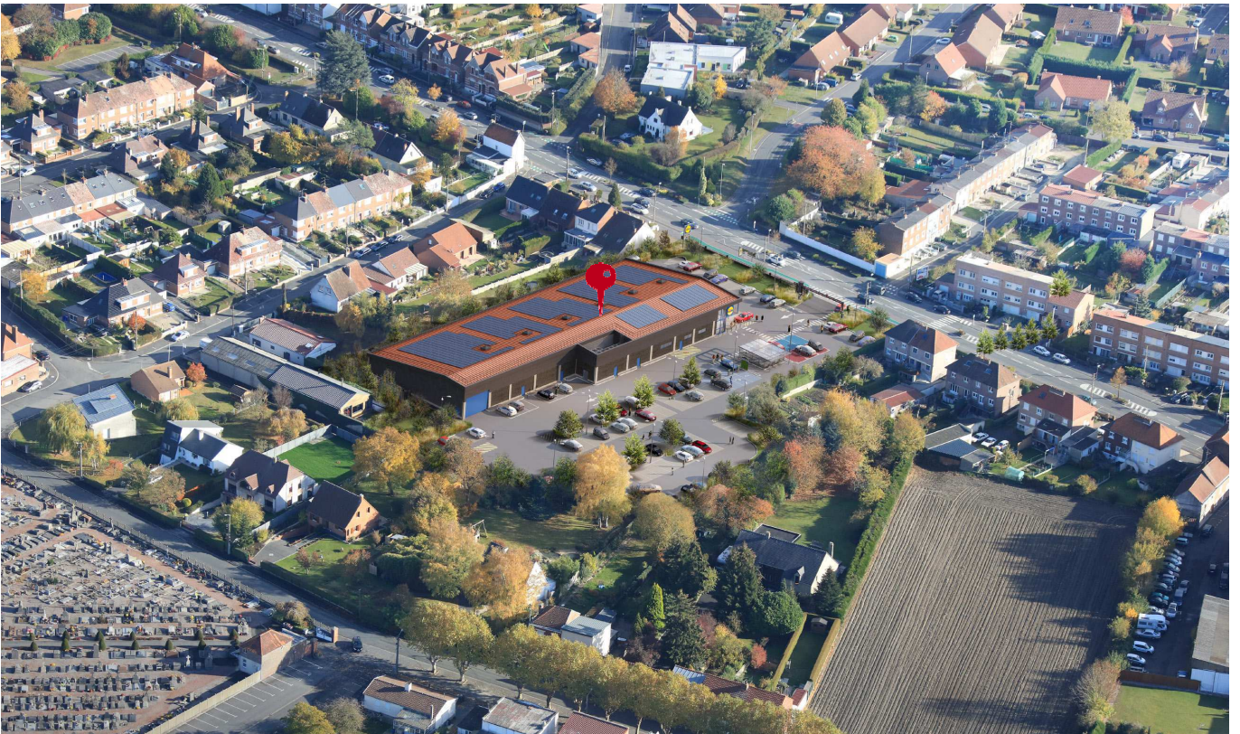
Vue du site après projet
