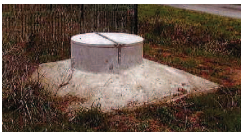
Photo de la protection d'une tête de forage
