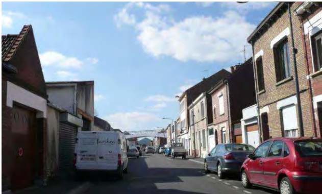
Secteur 1 : Rue Paul Bert/ maisons (R+2/R+2+c) en bande implantées en front à rue.
