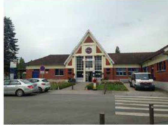
Dépose minute en lien avec le parvis gare
