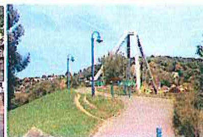
La passerelle sur l'Aisne (Vue n°6)
