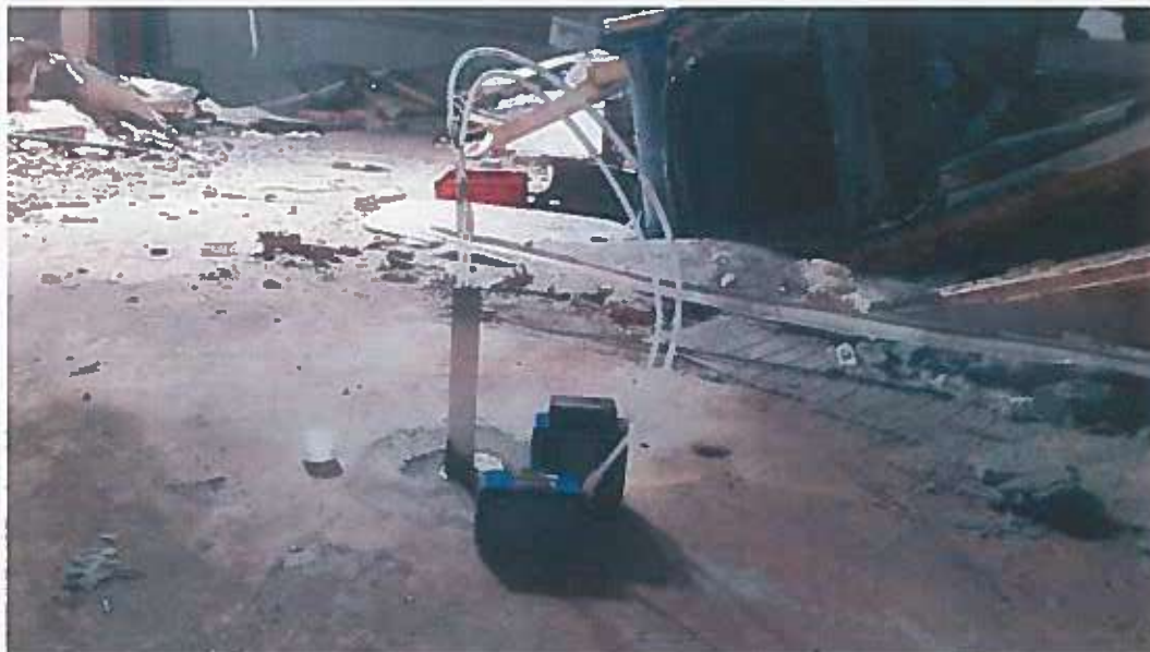
Figure 7.2 Prélèvement en cours au niveau d'un des piézairs du site
