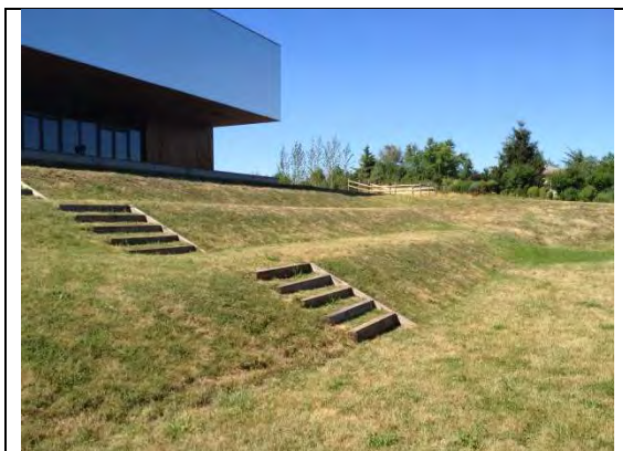
Exemple de talus engazonné avec emmarchement bois
