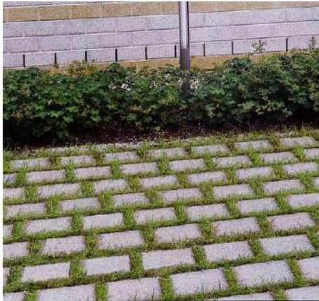
pavage à joints gazon en béton brut, gris clair
