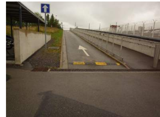
Rampe voitures et piétons entre parking Briqueterie et passerelle est
