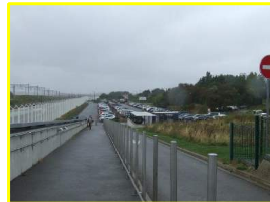
Rampe nouvellement aménagée
