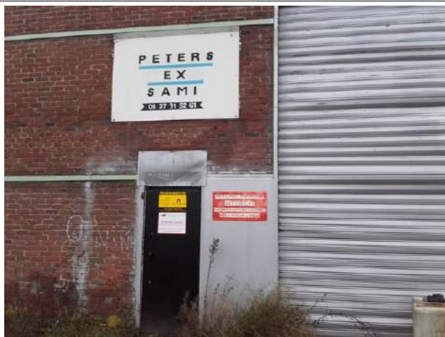
Photographie 3 : Sécurisation du bâtiment
