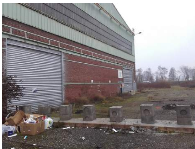
Photographie 1 : Blocs béton anti-intrusion, Sud du bâtiment
