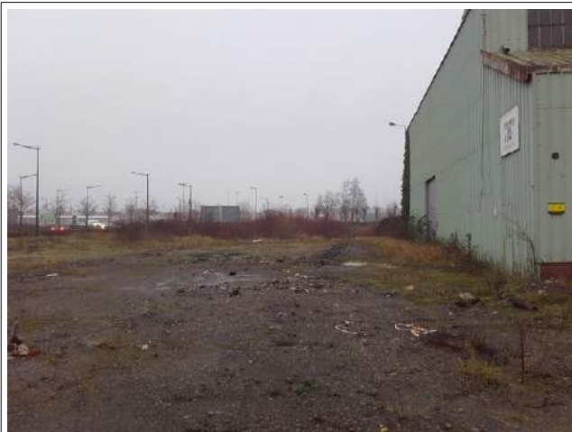
Photographie 5 : Vue du bâtiment principal – façade Nord
