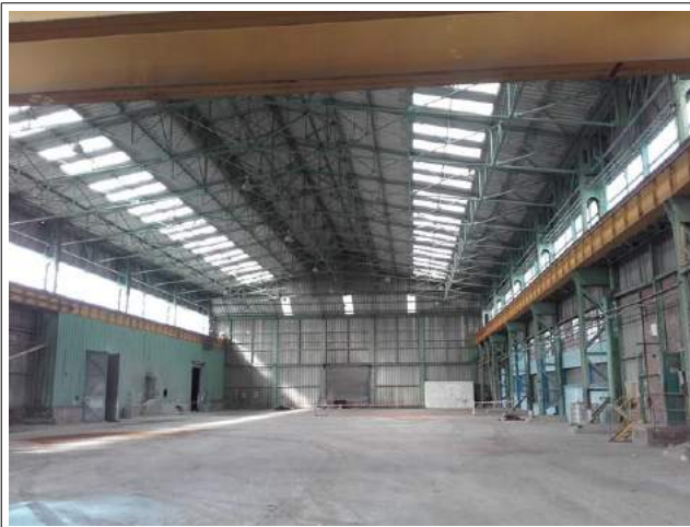
Photographie 11 : Vue générale de l'intérieur du bâtiment
