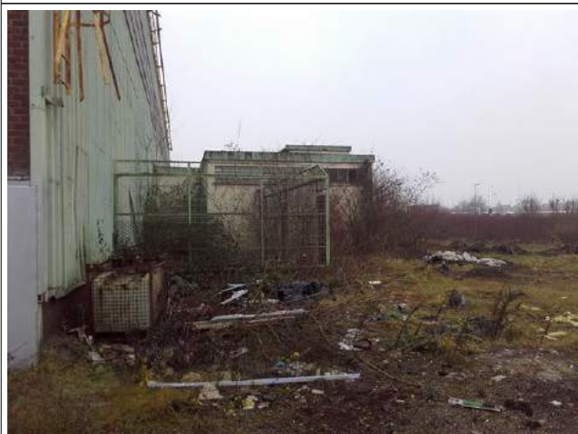
Photographie 7 : Déchets épars observés à l'Est du bâtiment
