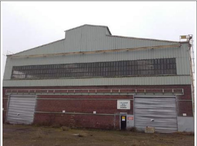
Photographie 6 : Vue du bâtiment principal – façade Sud
