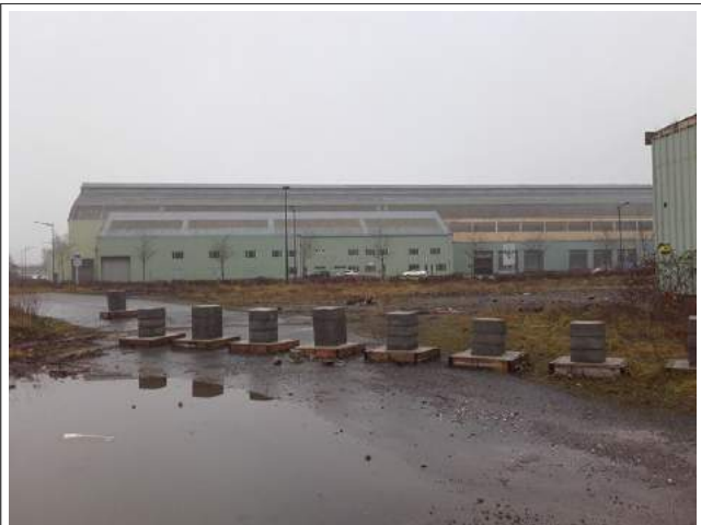
Photographie 2 : Blocs béton anti-intrusion, Nord du bâtiment
