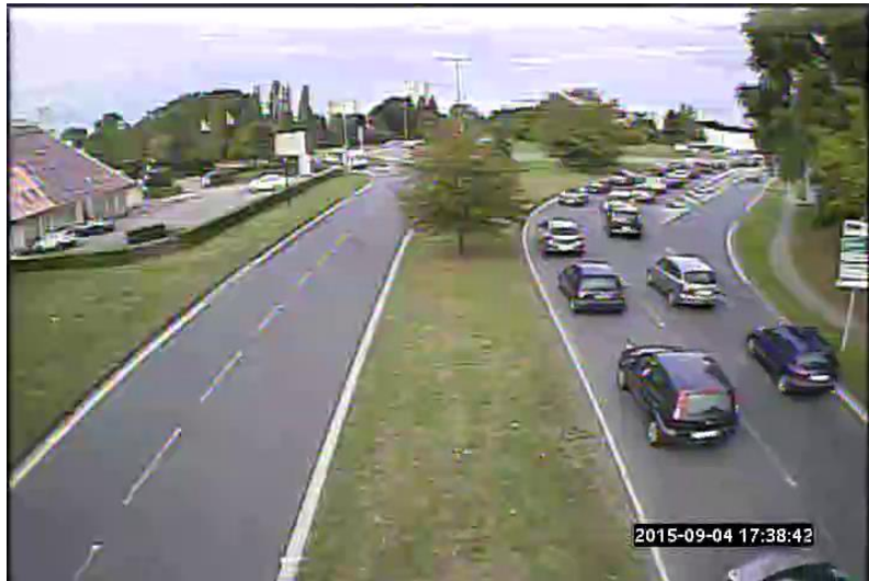
Vue sur la RD200 Sud
