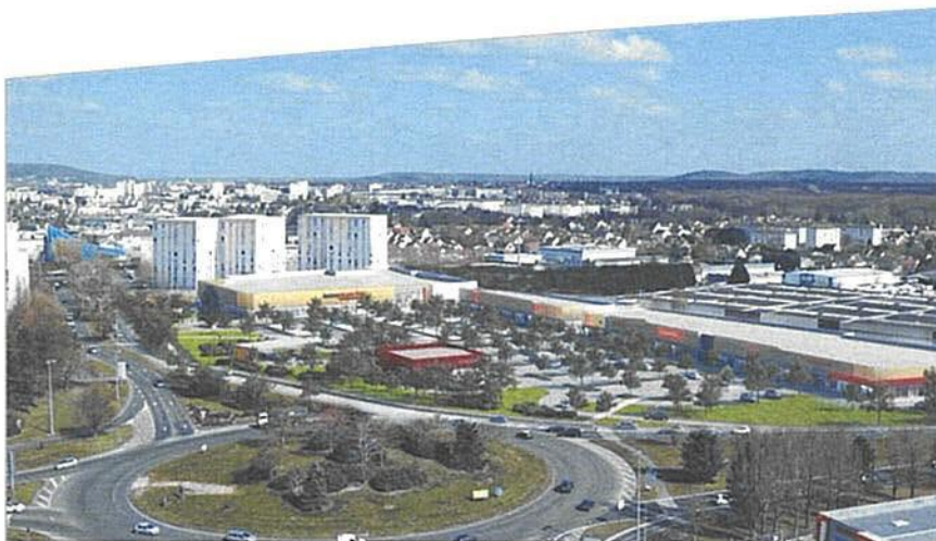
Vue globale du projet à partir du sud-ouest (au premier plan la rocade Sud)
