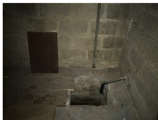
Vue n°6 : vue sur l'emplacement de l'ancienne pompe de relevage (sous-sol)
