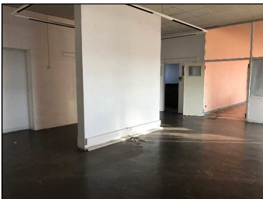
Vue n°3 : vue du hall d'entrée de l'auberge de jeunesse (RDC)
