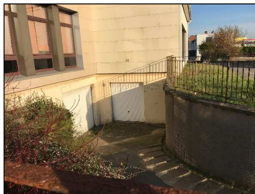
Vue n°8 : vue sur la rampe permettant l'accès au sous-sol
