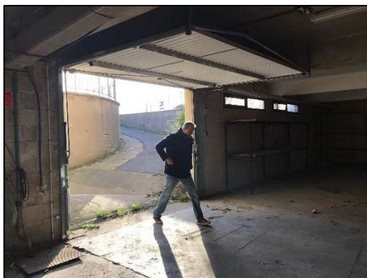
Vue n°7 : vue sur l'accès au sous-sol depuis l'extérieur
