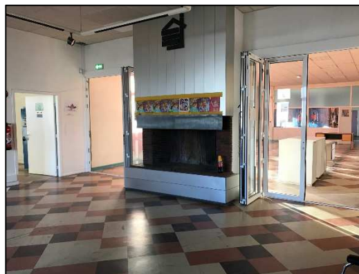
Vue n°4 : vue sur une salle de vie (RDC)
