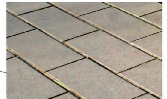
Voie piétonne en dalles béton 20x60
