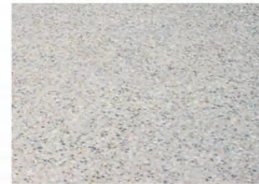
Trottoir "Liaison douce" en béton désactivé
