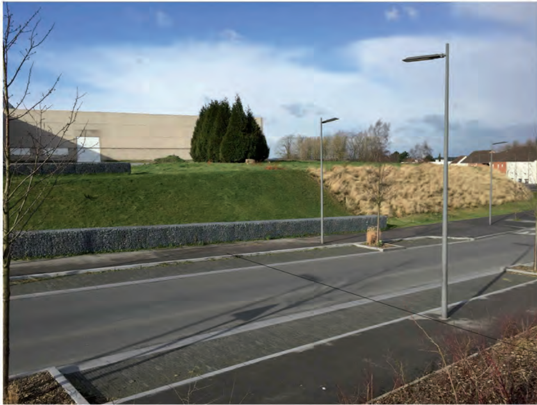
La bordure haute et le caniveau sont filants pour assurer une meilleure conduite des eaux pluviales
