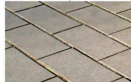
Voie piétonne de desserte du nouveau lot en dalles béton 20x60
