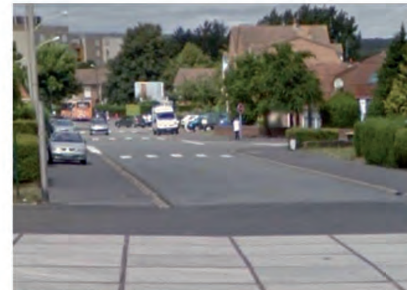
Accès traité avec des dalles béton cerclées 2x2m en cohérence avec les aménagements de la phase 1 pour la rue de Champagne
