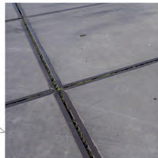
Placettes en dalles béton 2x2m cerclées au centre... et non cerclées en périphérie
