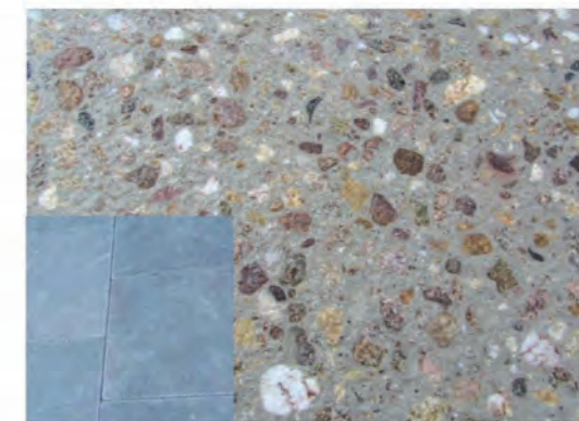
Axe majeur en béton bouchardé avec inclusion de zones en pierre bleue
