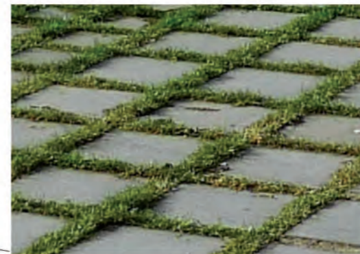
Stationnement en pavés engazonnés
