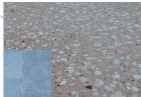
Axe majeur en béton bouchardé avec inclusion de zones en pierre bleue
