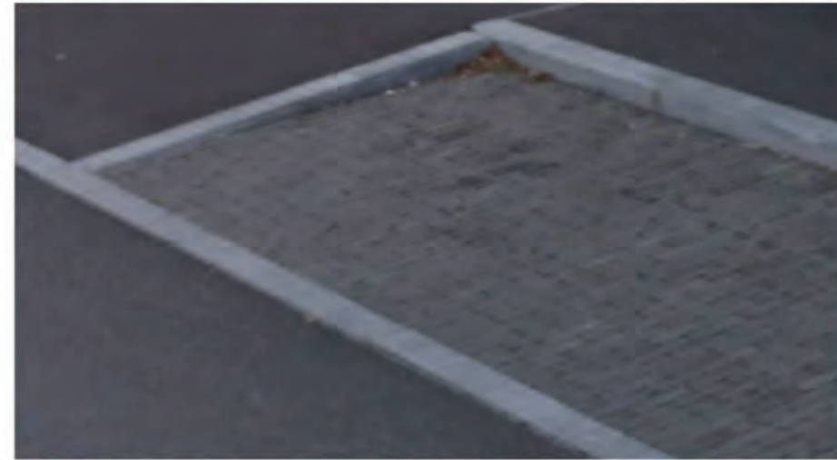
Les rampes d'accès véhicules permettent d'obtenir un trottoir plus régulier en évitant les bateaux
