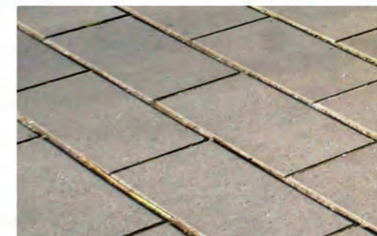
Voie piétonne en dalles béton 20x60
