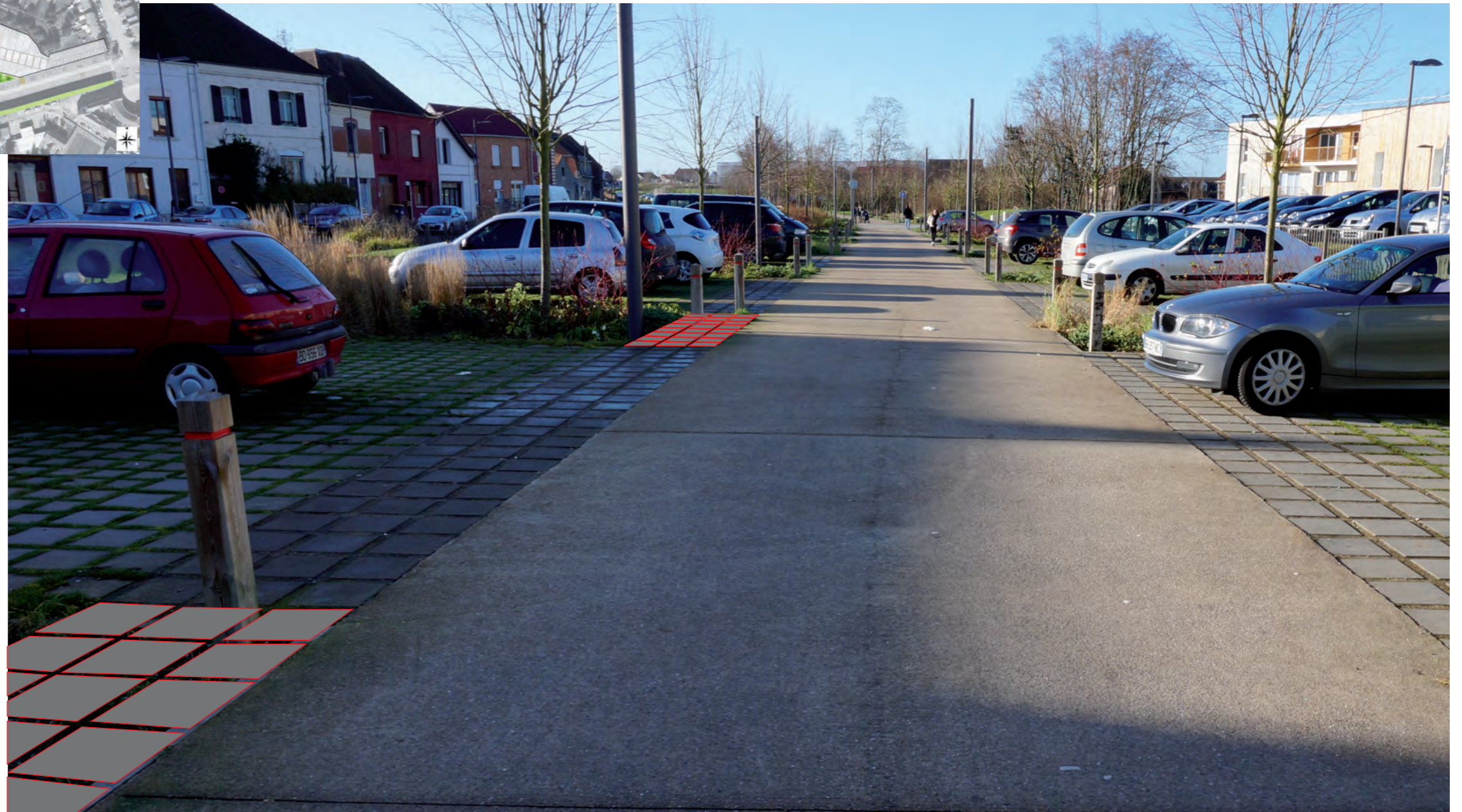
Axe existant avec stationnements en pavés à joints gazon : largeur 4m profondeur des stationnements de 6m
