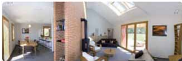
Ce projet exploite la transmission du rayonnement solaire sur un mur de masse en briques à travers des vitrages en façade et en toiture.
