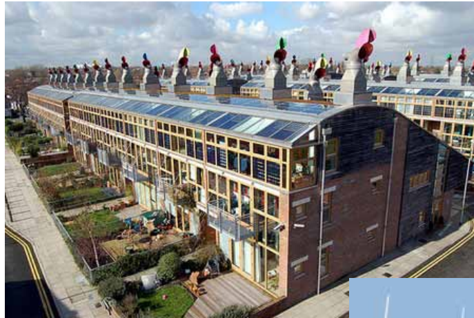
Logements BEDZED (GB)
