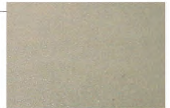
Chemin sur talus en sablé stabilisé
