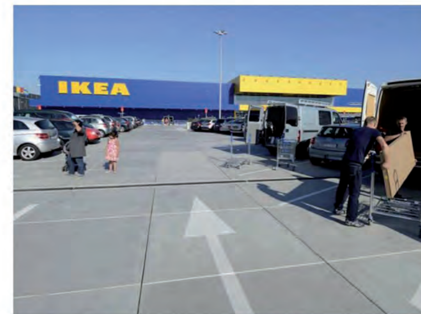
Dalles béton 2x2m sur un parking Ikéa
