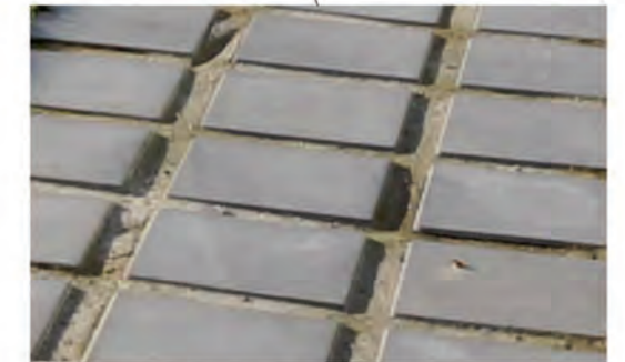
Pavés à joint mortier
