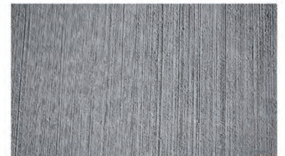
Voie mixte en béton balayé dans la suite du mail / promenade
