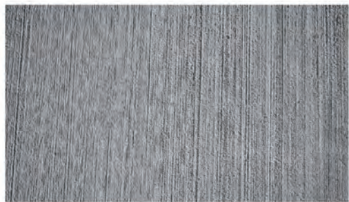
Passepieds en béton pour les stationnements le long du BHNS
