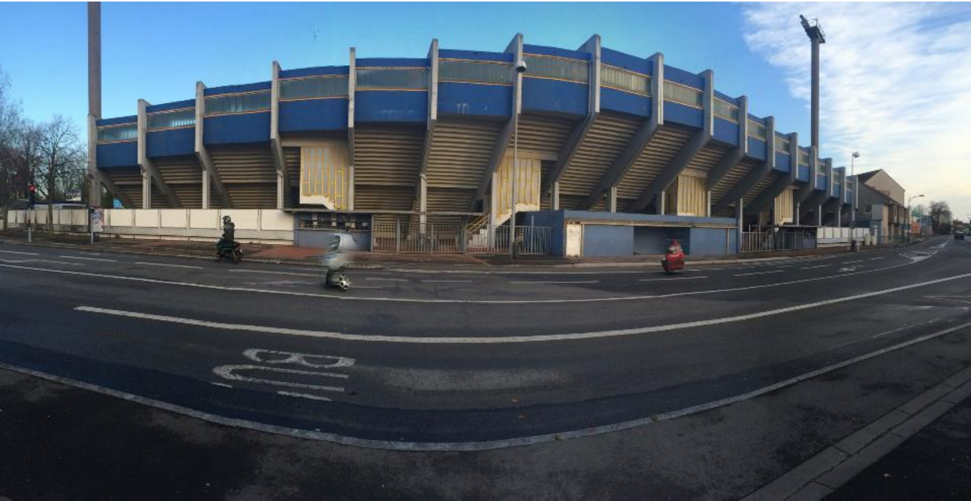
Vue sur la façade de la tribune Sud – Enjeux de façade ?
