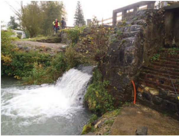
Vue aval de l'ouvrage (Source : Cariçaie)
