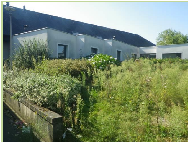
Zone de pelouse en friche et massif horticole à l'arrière du bâtiment
