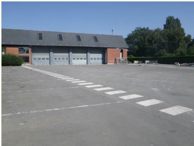
Vue sur les espaces artificialisés
