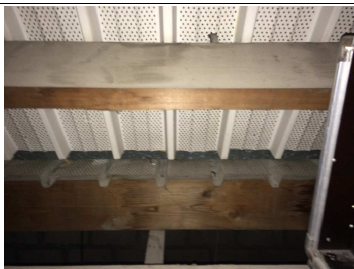
Tôle perforée de la toiture côté intérieur
