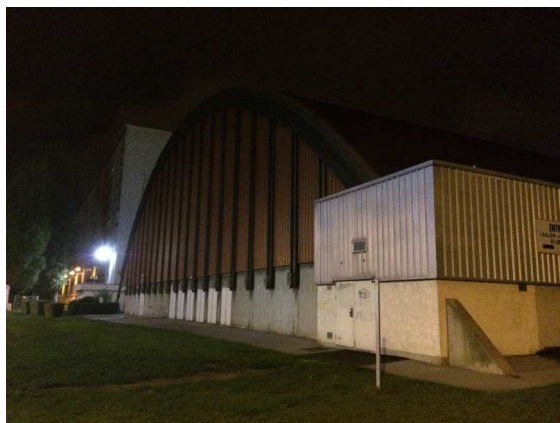
Vue depuis l'extérieur à l'arrière
