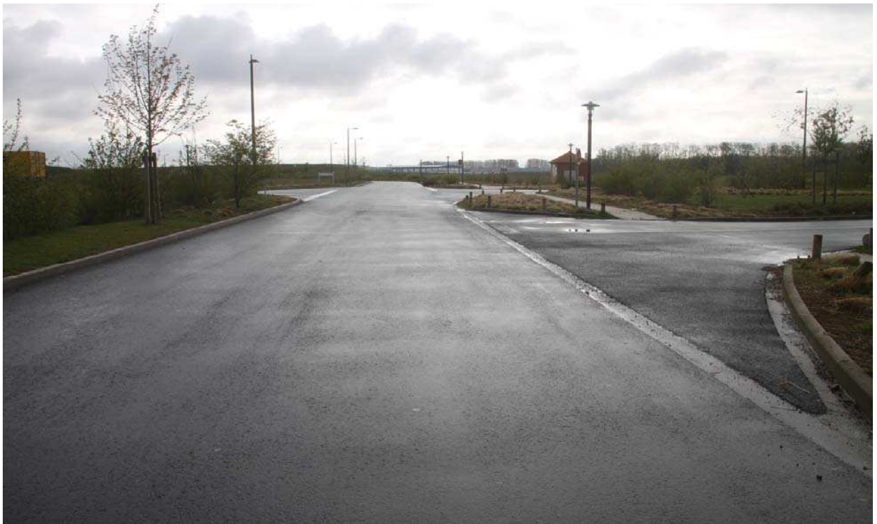
PC8 – 3 Vue du site depuis la voie de desserte publique vers le nord-est
