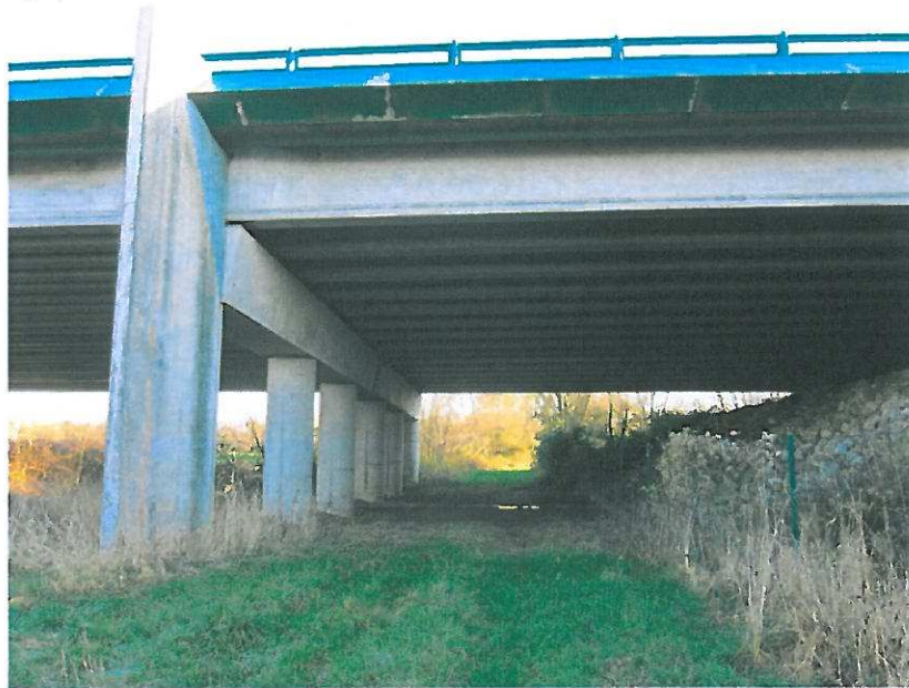
3 - 4 - Vues sur l'ouvrage d'art de l'A16 depuis le Nord-Ouest
