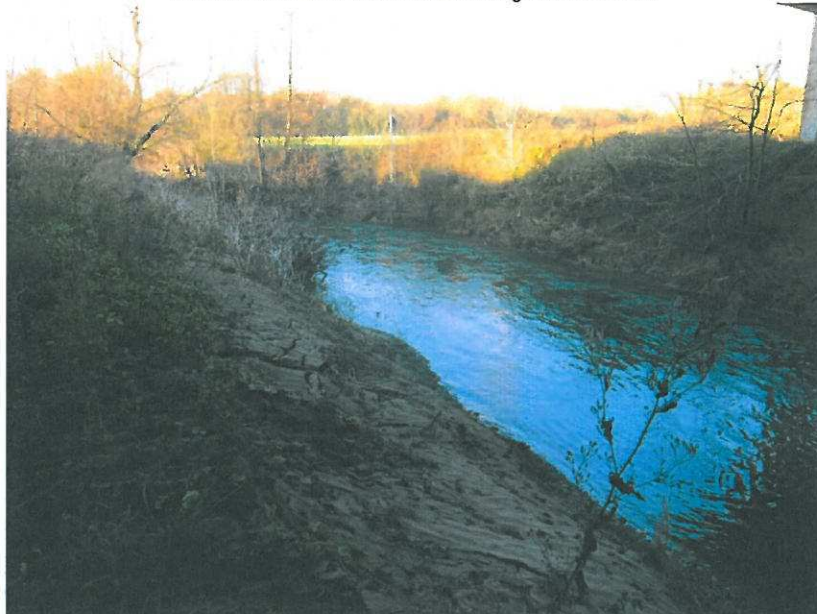
7 - Vue de la berge Sud de la Liane en aval de l'ouvrage d'art de l'A16
