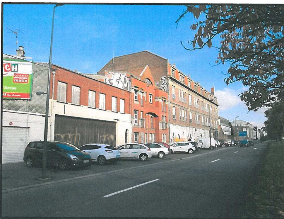
Photo n°1 : Boulevard de Strasbourg direction Ouest (prise de vue : 13.11.13)
