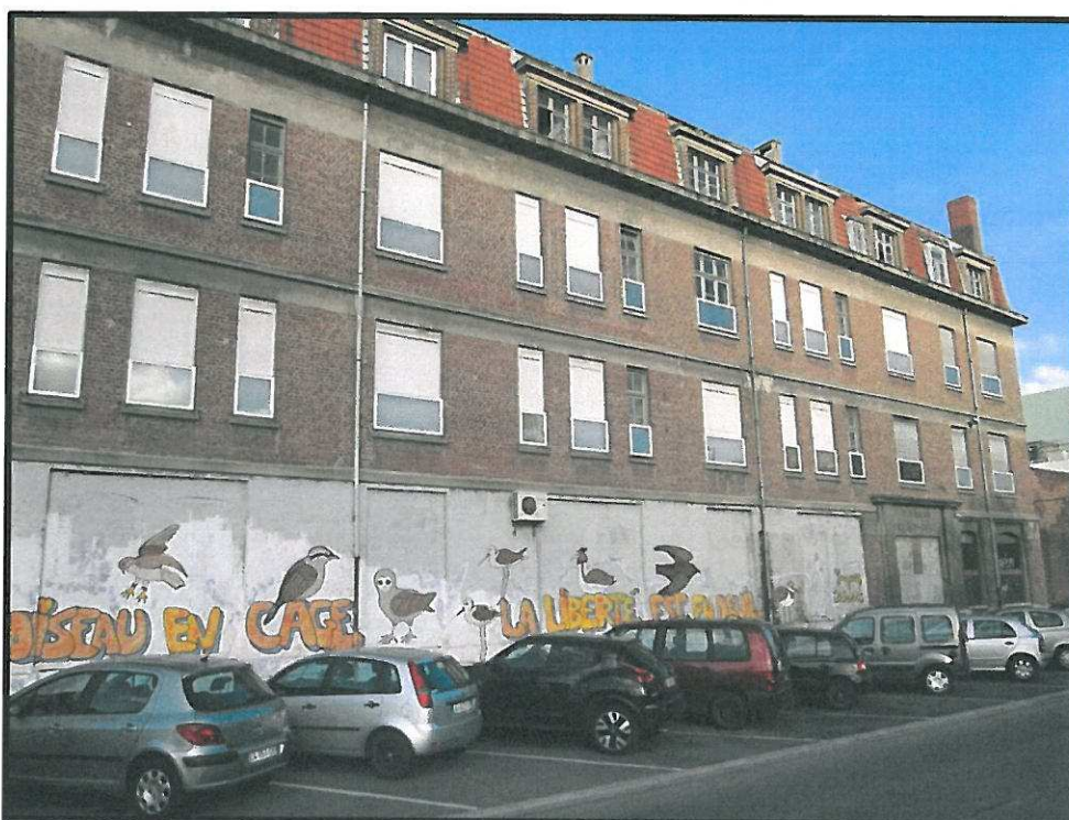
Photo n°2 : Boulevard de Strasbourg direction Ouest (prise de vue : 13.11.13)
