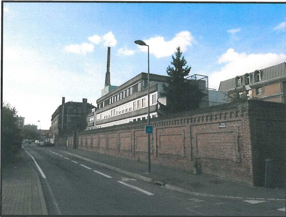
Photo n°3 : Boulevard de Strasbourg direction Est (prise de vue : 13.11.13)
