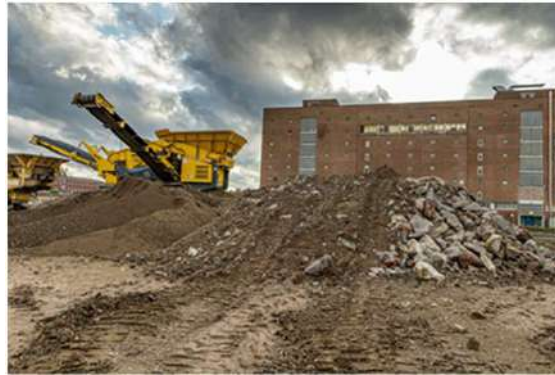
Economie circulaire sur les chantiers de déconstruction
